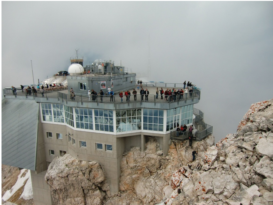
Abbildung 34: Der Blick vom Zugspitzgipfel über die Anlagen
